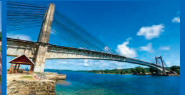
日本・パラオ友好の橋(パラオ)
